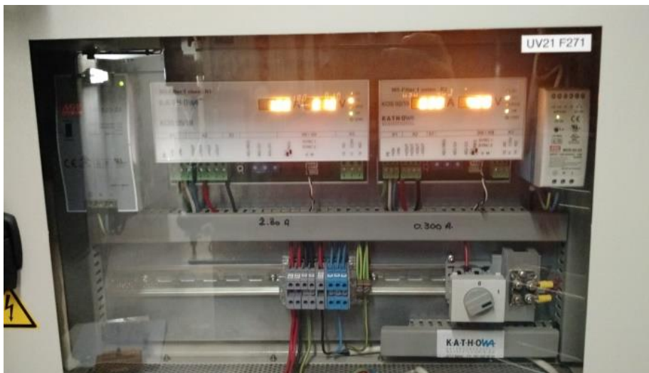
Abbildung 26 + 27: Kathodenschutzanlage und Umwälzpumpe
