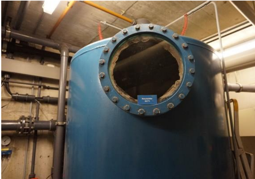
Abbildung 24 + 25: Mehrschichtfilter
